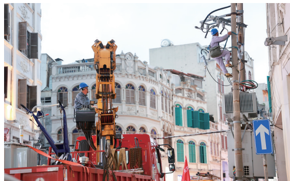
抢修队伍正在海口美兰区骑楼老街吊装变压器。陈美影 摄
