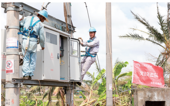
工作人员正在更换配电箱。黄琦之 摄
