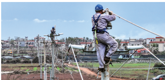
抢修队伍对湛江徐闻县西连镇开展线路加固工作。梁宇宏 摄
