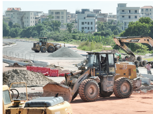
正在建设中的文才路。通讯员黄林明摄
