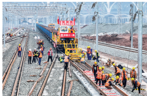
这是11月2日拍摄的渝厦高铁重庆东站正线铺轨施工现场(无人机照片)。
