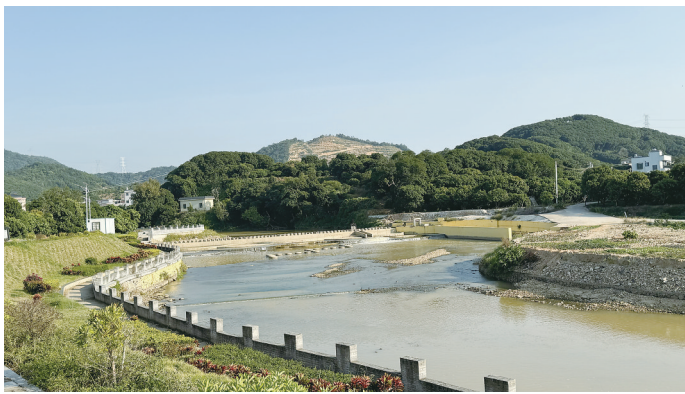
正在施工的楼梯状灯光叠水区。(元坝村供图)
