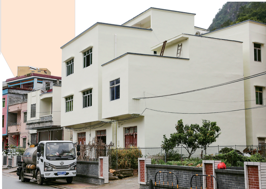
外立面改造后的房屋整齐美观。
