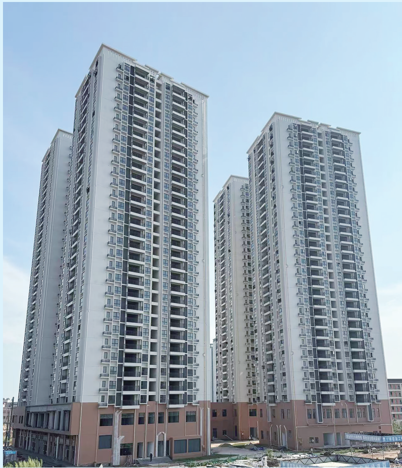
化州市棚户区原市建筑陶瓷厂改造工程(A区一、二期)项目
