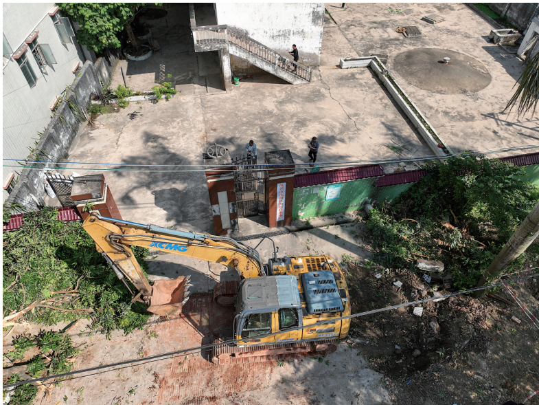
拆除现场钩机正在作业。 茂名晚报通讯员黄林明 摄
