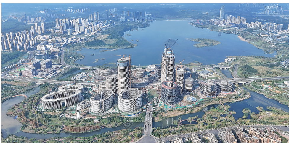
这是位于四川天府新区兴隆湖畔正在修建中的成都科创生态岛(2024年10月23日摄,无人机照片)。 新华社记者刘坤摄
