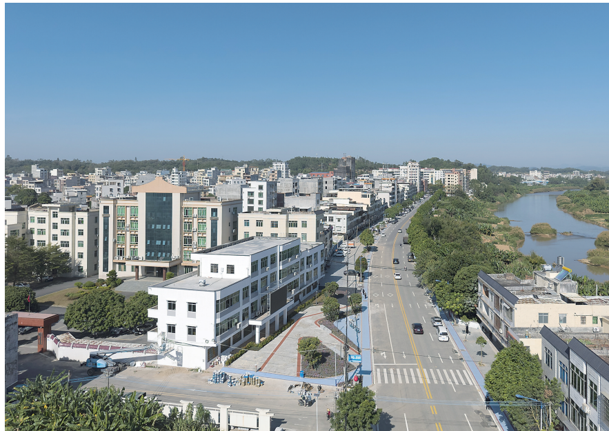
大井镇圩街正在进行外立面改造。
