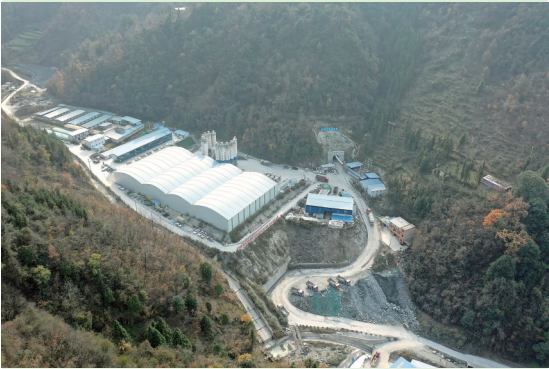
图为华家山隧道建设现场。(中铁十九局供图)
