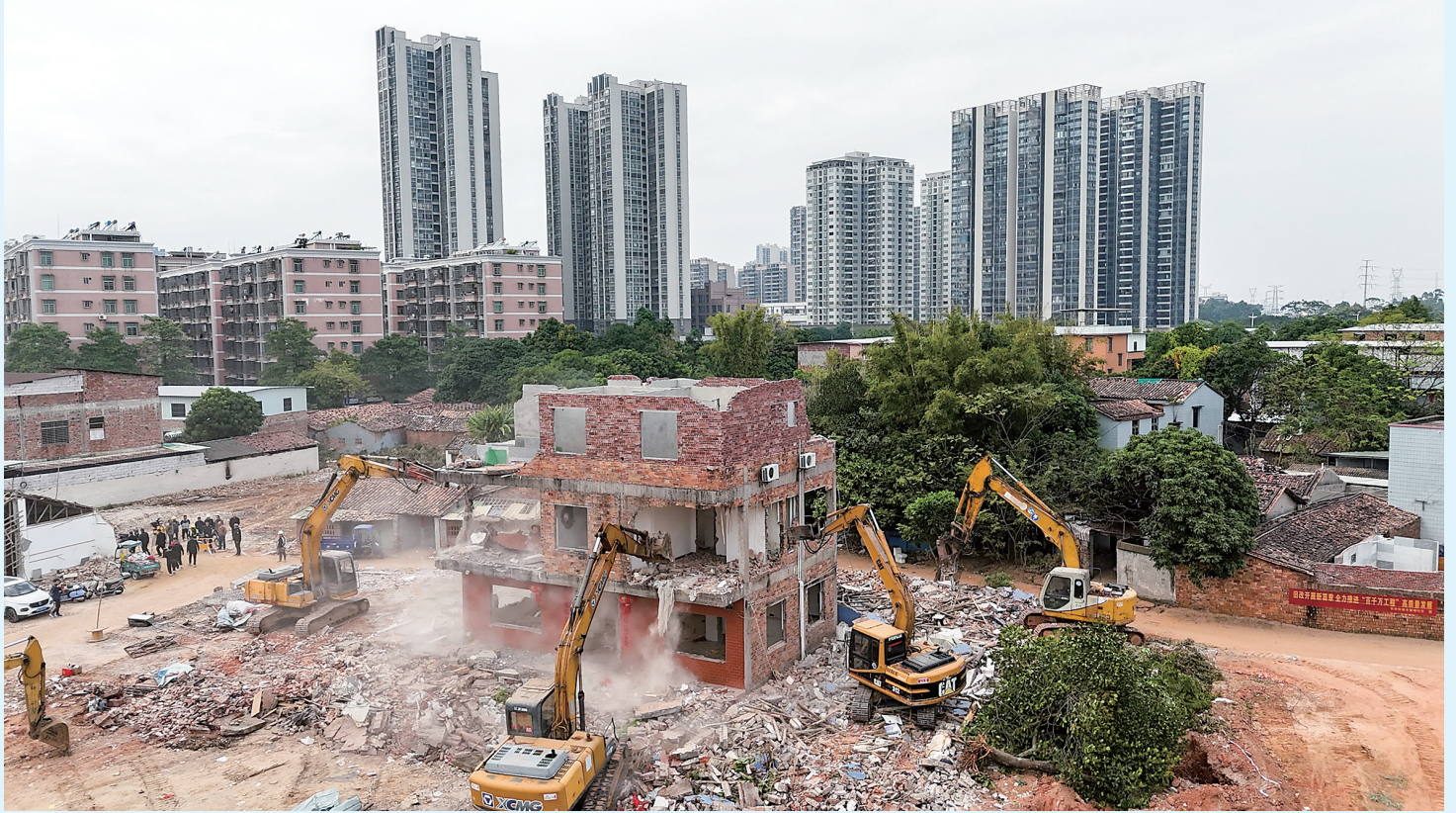
拆迁现场。通讯员黄林明 摄
