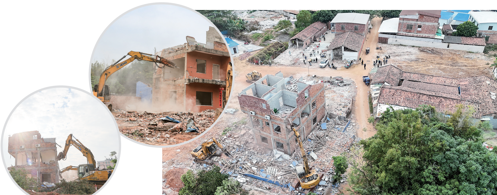
拆迁现场。通讯员黄林明 摄
