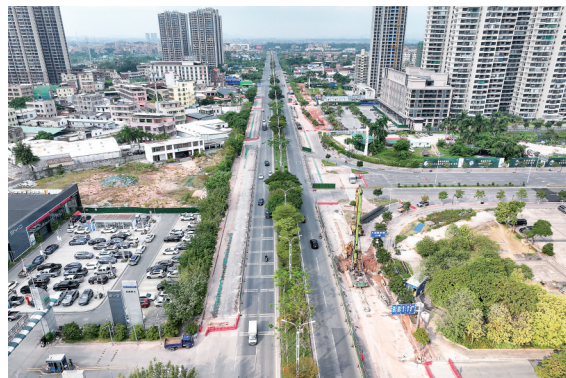
茂名大道与官山路交接处施工情况。
