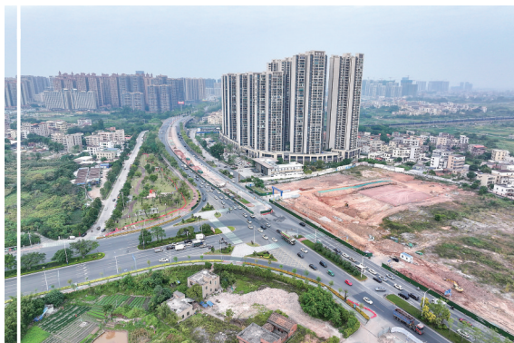
茂南大道节点施工现场。
