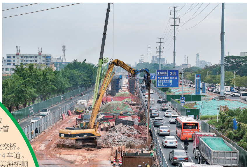
市民大道节点施工现场。
