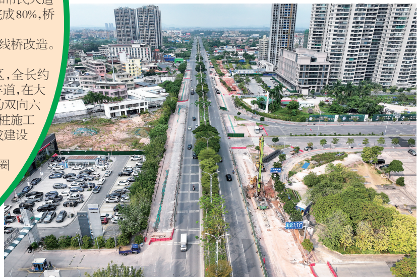
茂名大道与官山路交接处施工情况。
