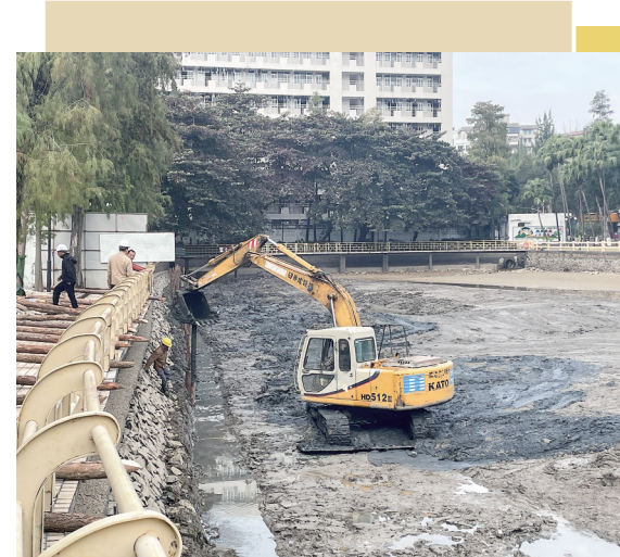
昨天,一辆工程车在茂名市中心城区集雨湖1号湖进行清淤工作。据了解,1号湖的清淤工作预计在元旦前完成。
