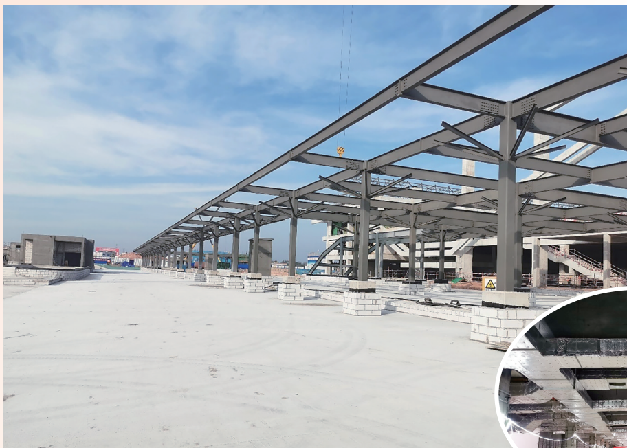
▲风雨连廊钢结构施工。
