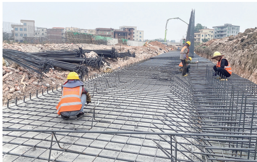
市民大道西延线电白段施工现场。茂名晚报记者刘锋兰 摄
