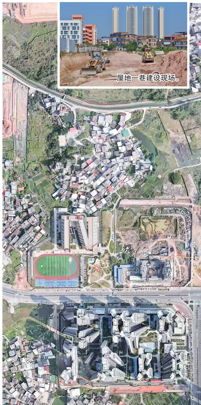
街坊路航拍图。施工单位供图
