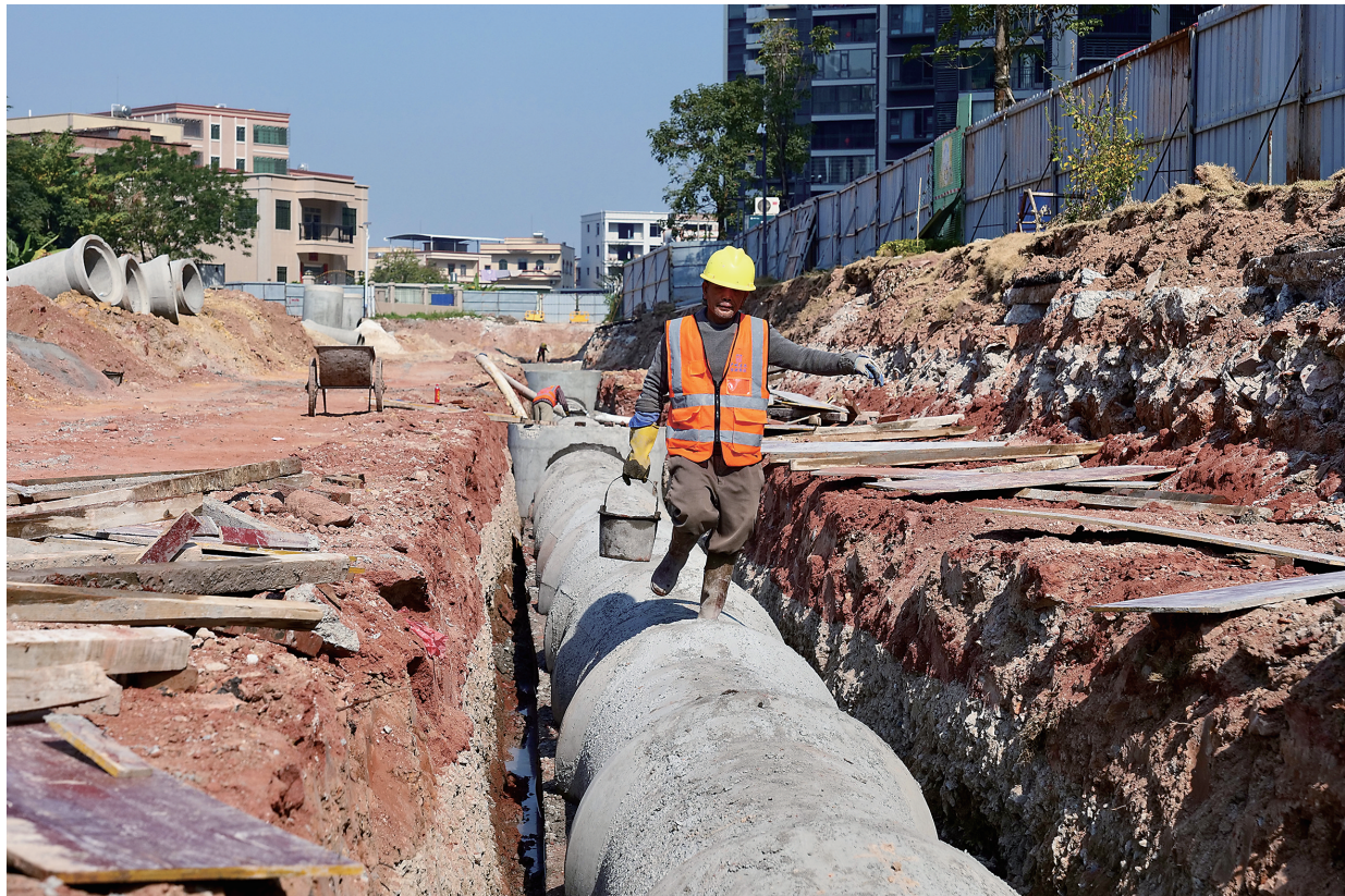
黄塘四巷建设现场。
