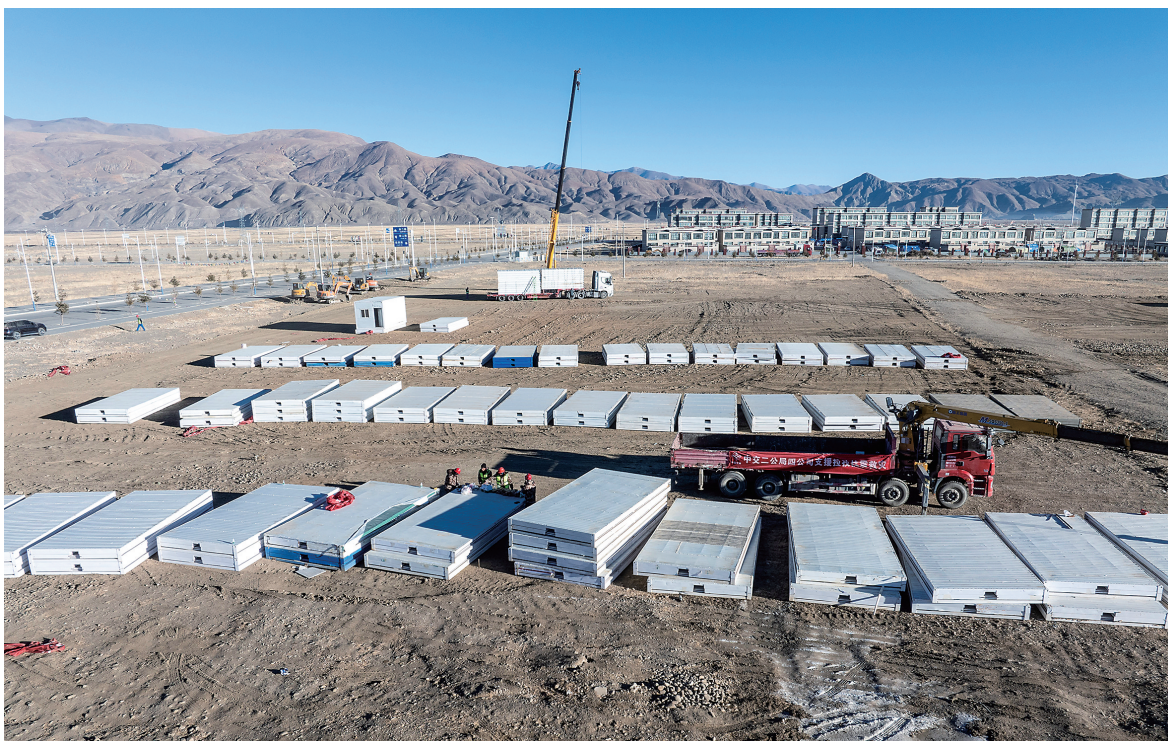
1月10日,工人在施工现场搭建活动房屋(无人机照片)。 新华社记者 姜帆 摄
