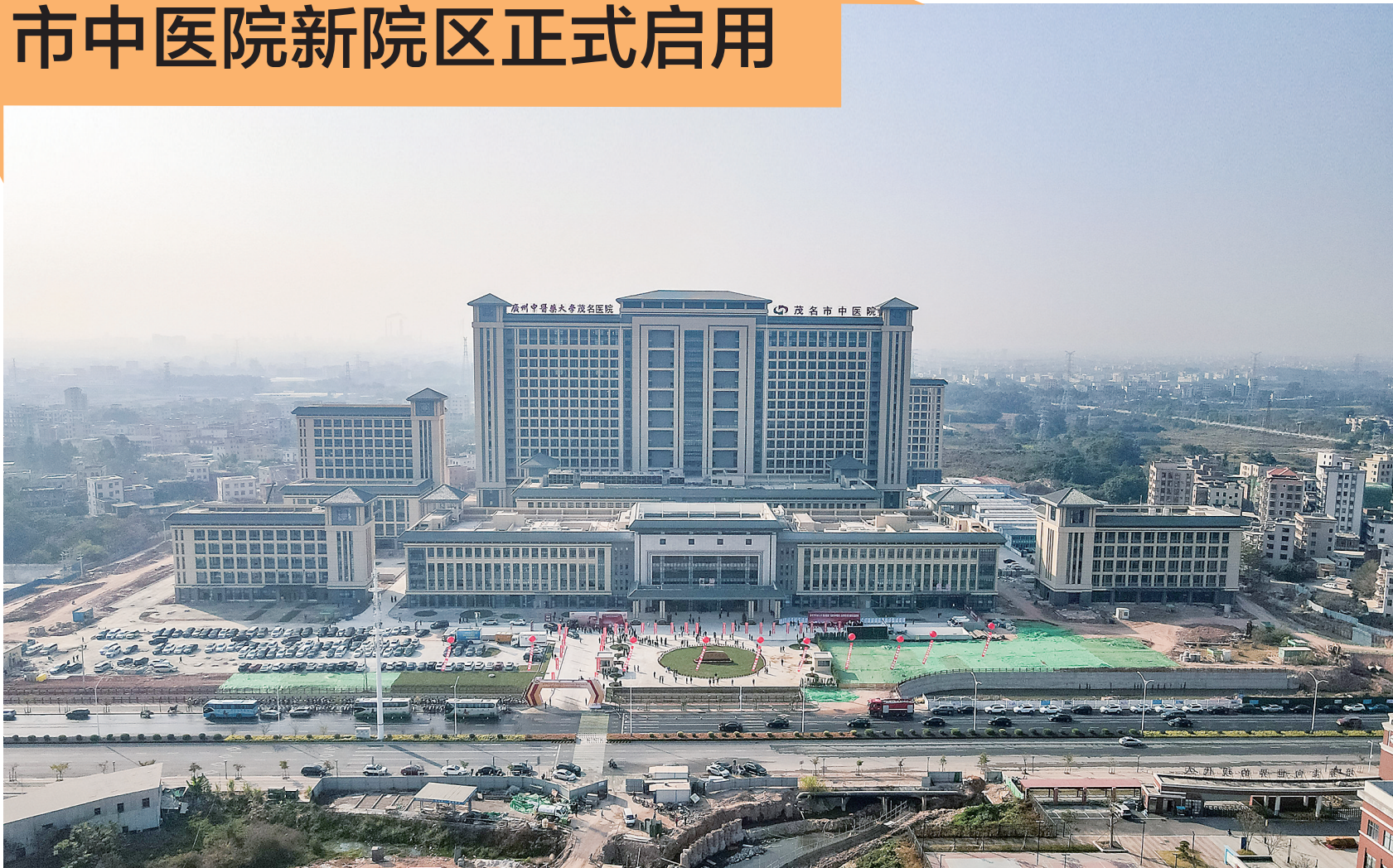
茂名市中医院新院区航拍。茂名日报社全媒体记者 吴昊 摄
