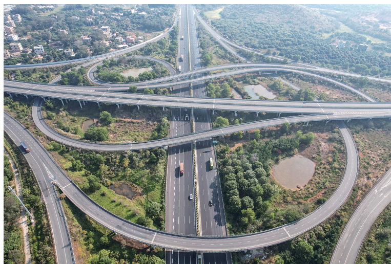
茂湛高速大昌口枢纽互通立交(连接包茂高速粤境段)路段双向八车道路面通行顺畅。
