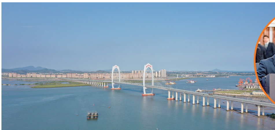
▲电白水东湾大桥
