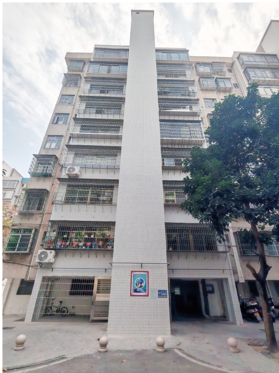
老旧小区的楼房已加装好电梯 通讯员茂健摄 年将其列为重点民生补短板工程、民生实事项目,建立“市级统筹、区级实施、街道落实”的三级管理体系,强化组织领导和统筹协调。
