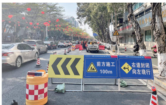
施工现场。茂名日报社全媒体记者 李颜东 摄
