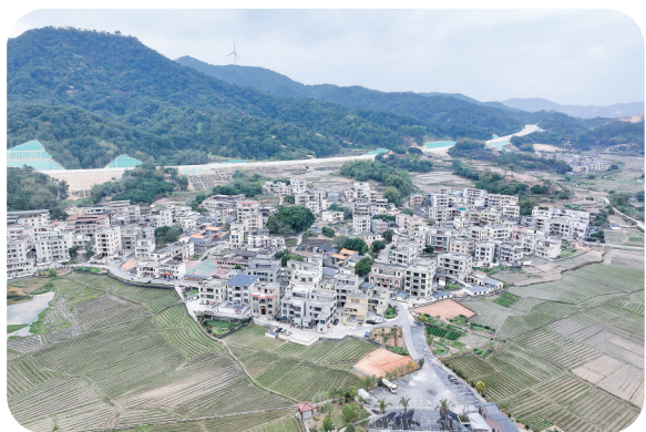
明堂村航拍全景。
