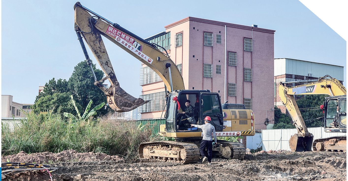
施工现场。 茂名日报社全媒体记者 张波 摄
