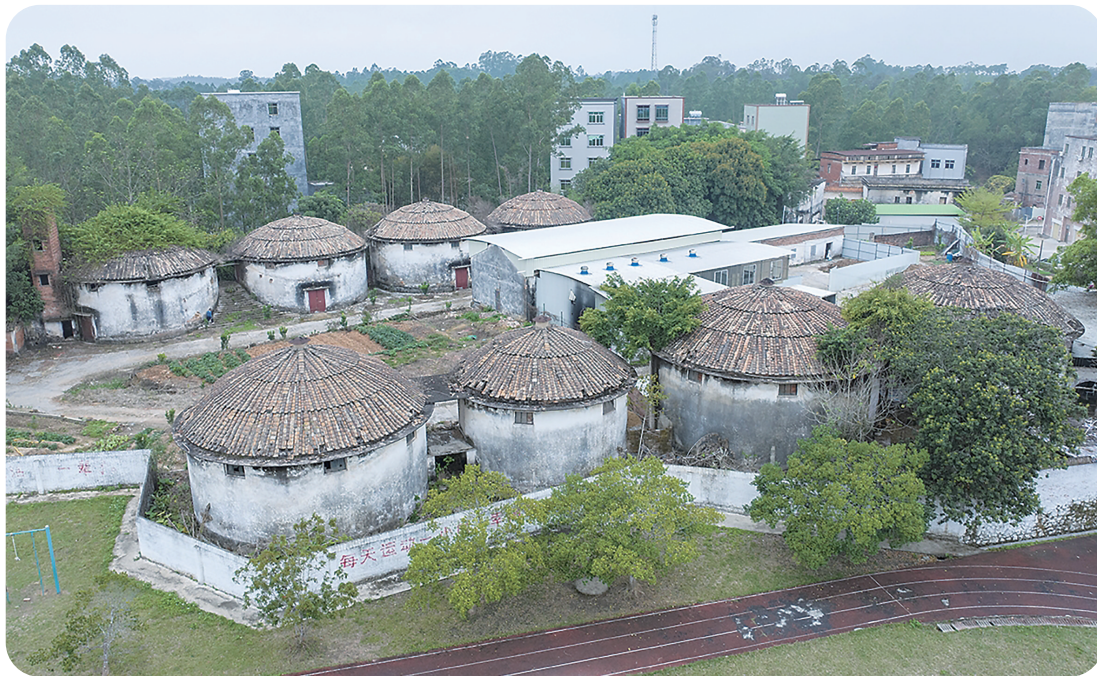
八座形如古堡的圆形粮仓，为储粮筑起安全屏障。茂名日报社全媒体记者甘杨松摄
