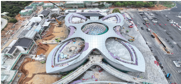
即将交付使用的柏桥服务区
