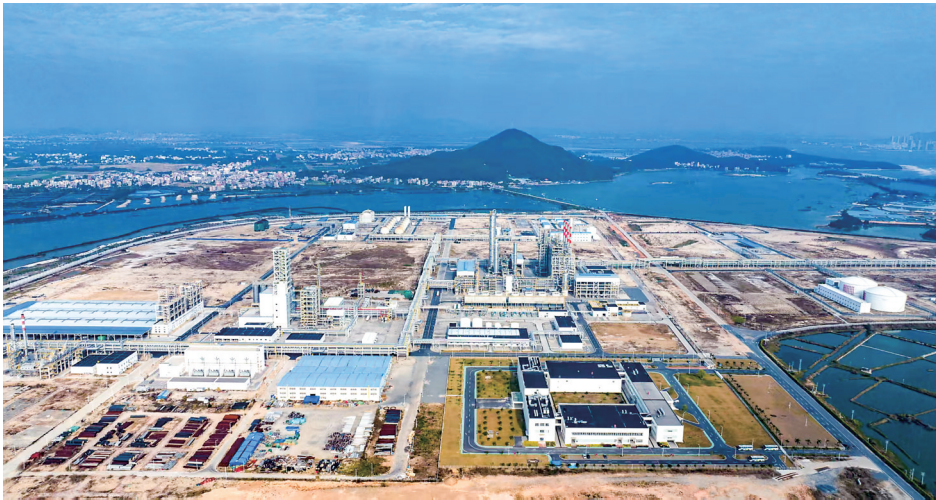
东华能源(茂名)烷烃资源综合利用项目。
