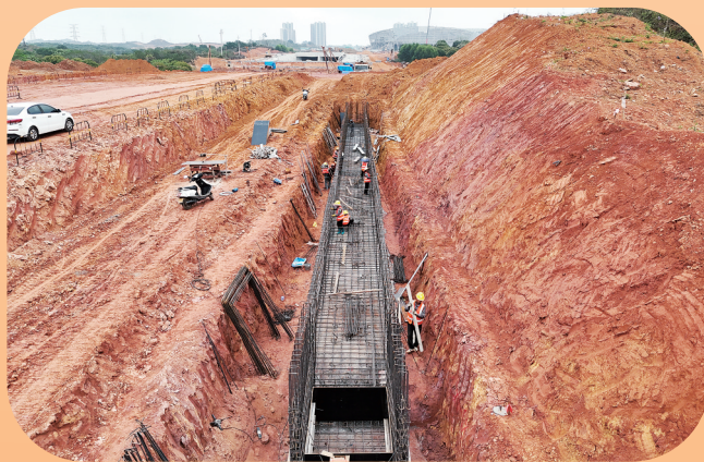
奥体大道二期地下管廊施工现场。
