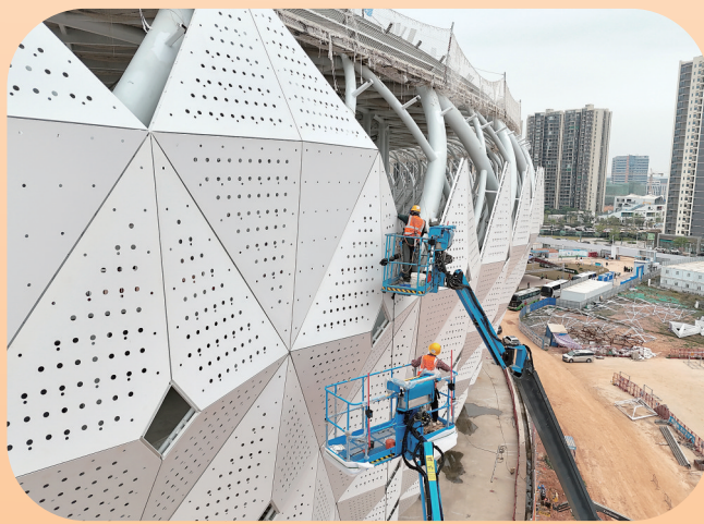
工人在主场馆外墙挂设隔板。
