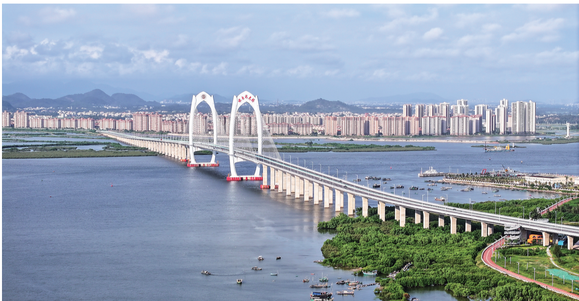
水东湾跨海大桥。
