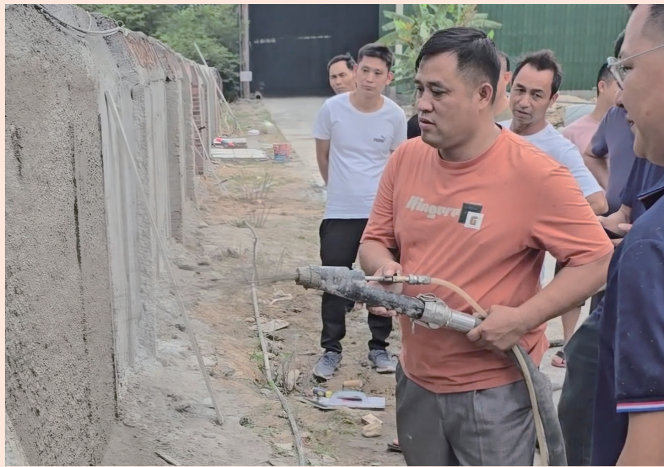
机喷砂浆打浆技术展示现场。茂名日报社全媒体记者李陶然 蔡杨颖琳摄
