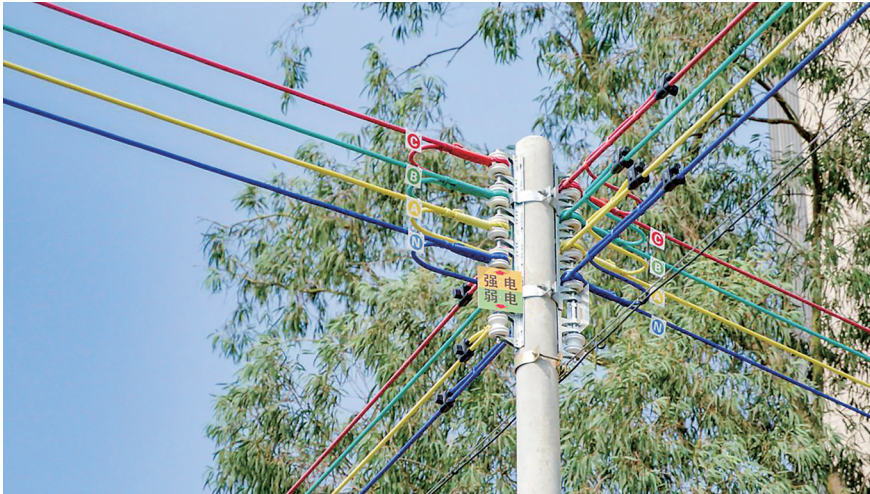
通过“多网融合”的手段,整合强弱电线路规划,减少三线搭挂现象。
