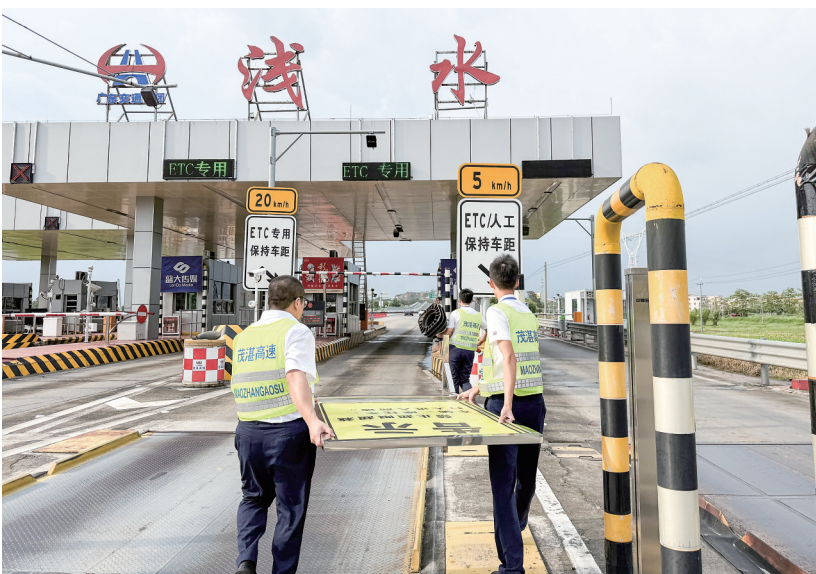
茂湛高速沿线站场对易吹落物品进行加固或清理。
