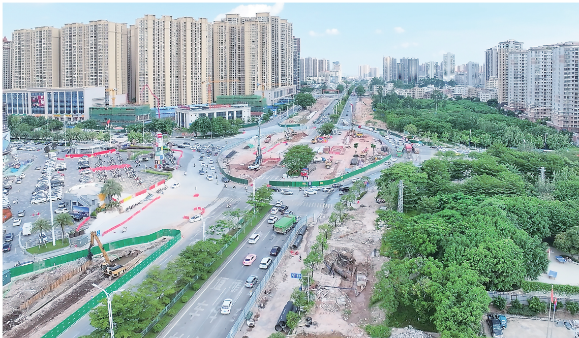
施工现场。茂名日报社全媒体记者李陶然 摄
