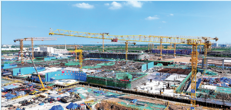
7月25日,在津潍高铁山东东营高铁站现代综合客运枢纽及配套工程建设现场,中铁二十局工作人员在施工(无人机照片)。
