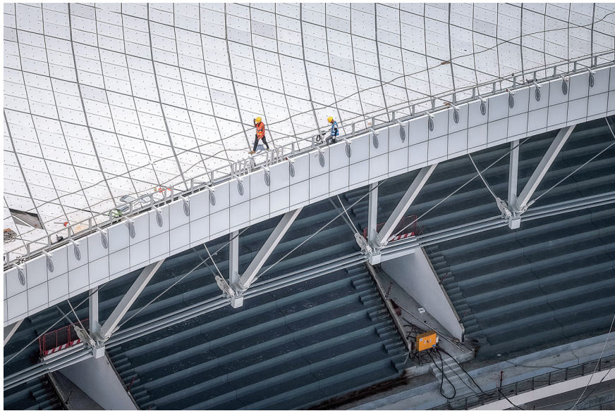
施工现场。茂名日报社全媒体记者 吴昊 摄
