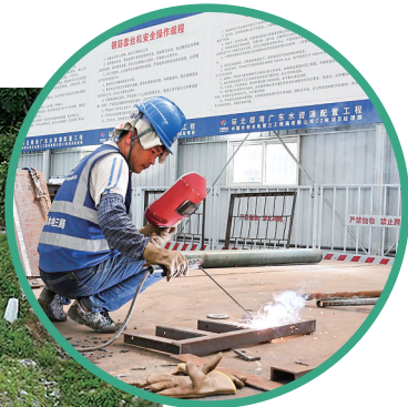
▲望夫出口TBM11“追赶号”工区电焊工正在焊接拱架部件。
