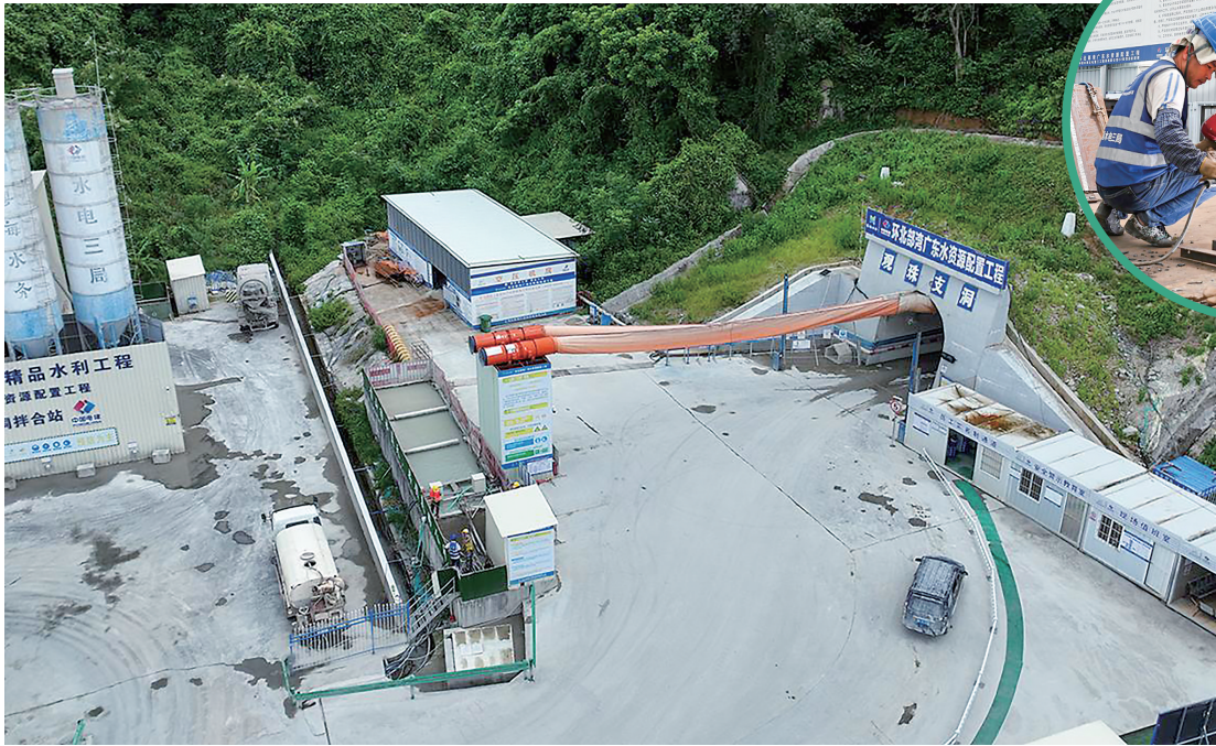
观珠隧洞洞口。
