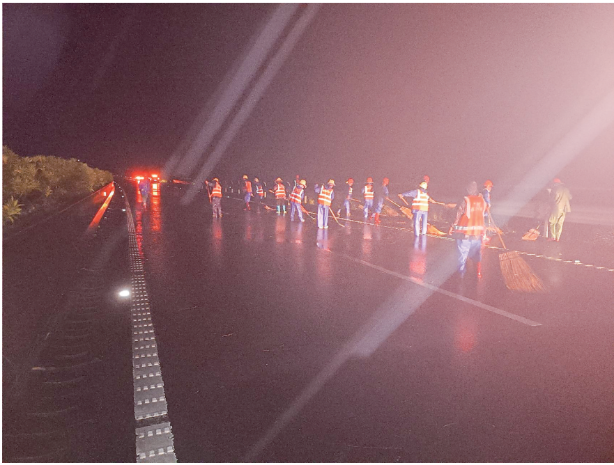
茂湛、包茂高速应急抢险人员连夜清理路障,为道路恢复通车努力。
