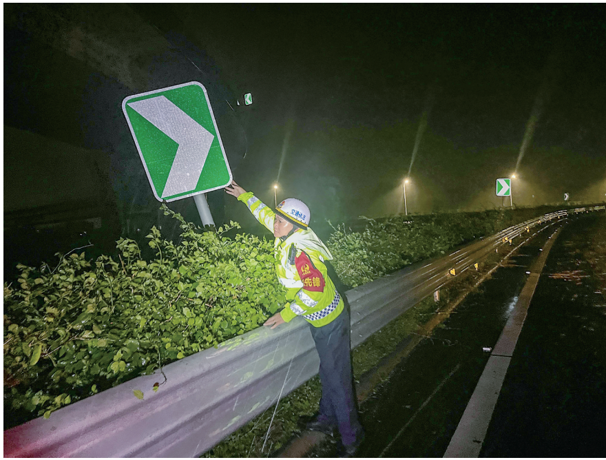
包茂高速路政员在风雨中扶正被吹歪的标志牌。
