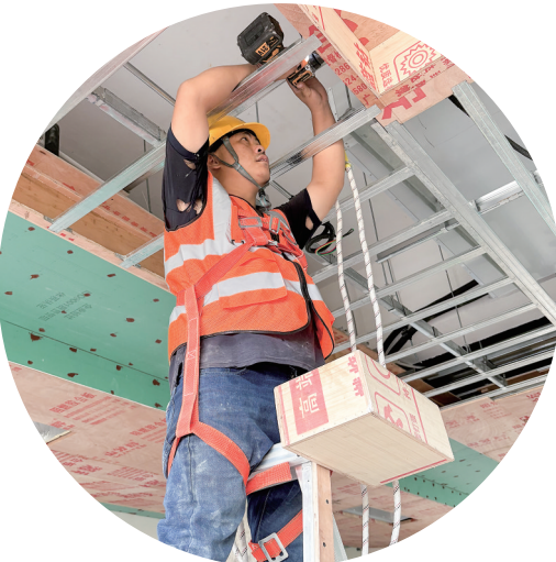
北界镇西江文化产业发展项目工人正在安装吊顶。通讯员供图
