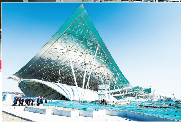
2月26日拍摄的北京城市副中心站综合交通枢纽工程和“京帆”屋盖。新华社记者 鞠焕宗 摄
