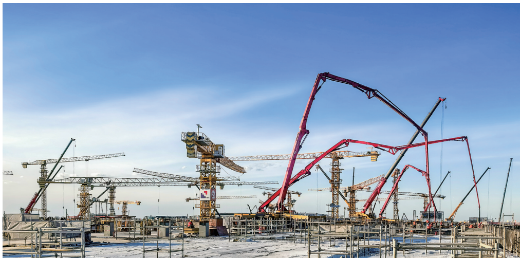
东方枢纽上海东站高架层混凝土浇筑现场。(受访者供图)
