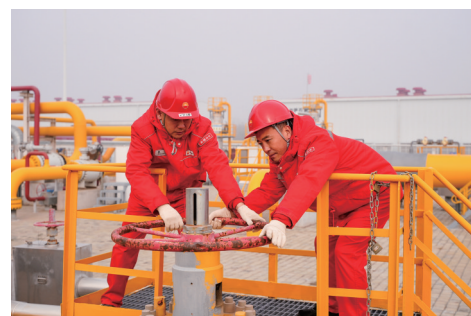
11月10日,呼图壁储气库员工缓缓打开出站球阀。(新华社发 薛梅 摄)
