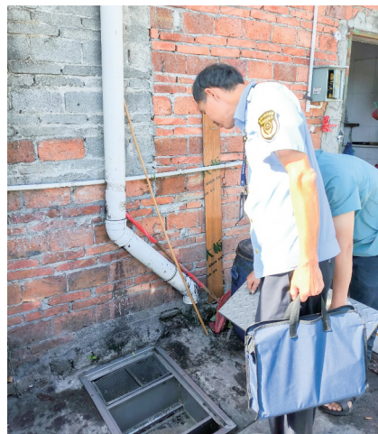
执法人员检查餐饮单位隔油隔渣装置。 通讯员供图
