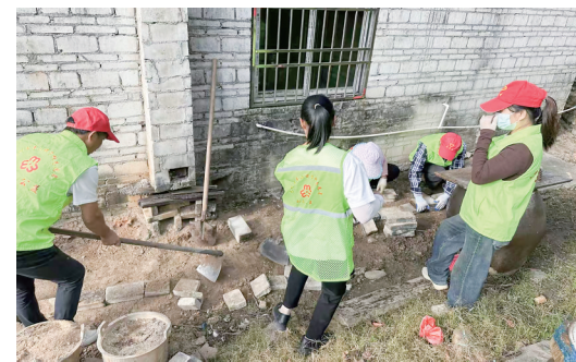
志愿者们正在进行沟渠硬底化施工。
