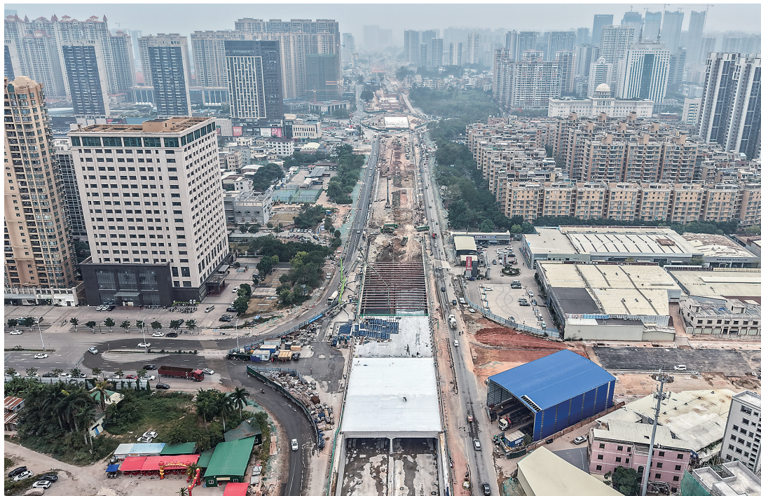
官山路暗埋路段封顶。茂名日报社全媒体记者张波 摄
