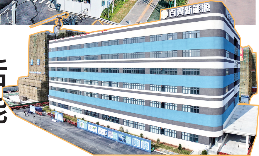
马店河新型储能产业园开园。 茂名日报社全媒体记者 张波 摄
