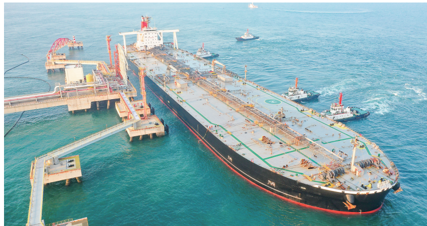
12月18日,一艘装载着石化原辅料的外籍船舶泊入国投洋浦油储码头30万吨级原油泊位(无人机照片)。
