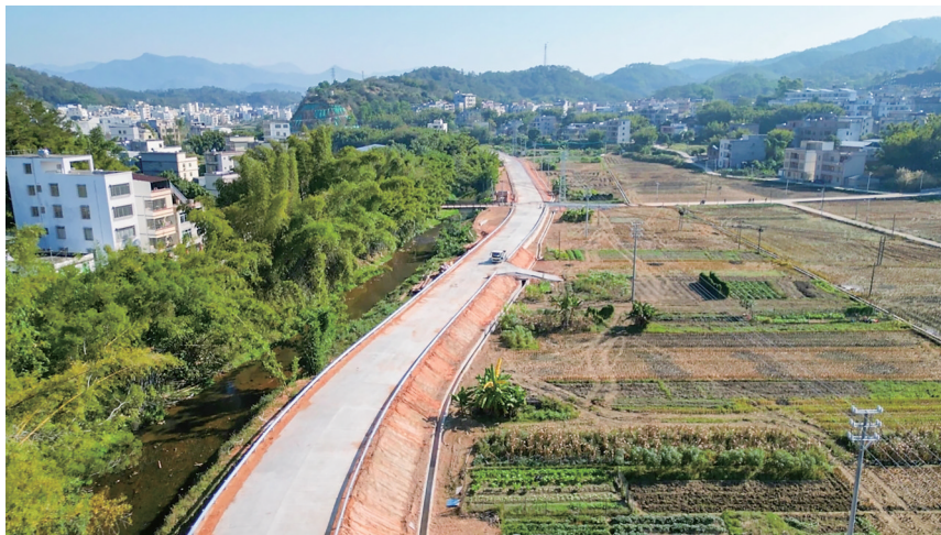
道路已完成混凝土路面铺设。通讯员供图
