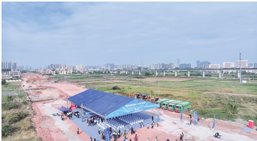
省道S280线改建工程(东环大道)(一期)跨铁路特大桥开工启动仪式现场。黄宇彬 摄
