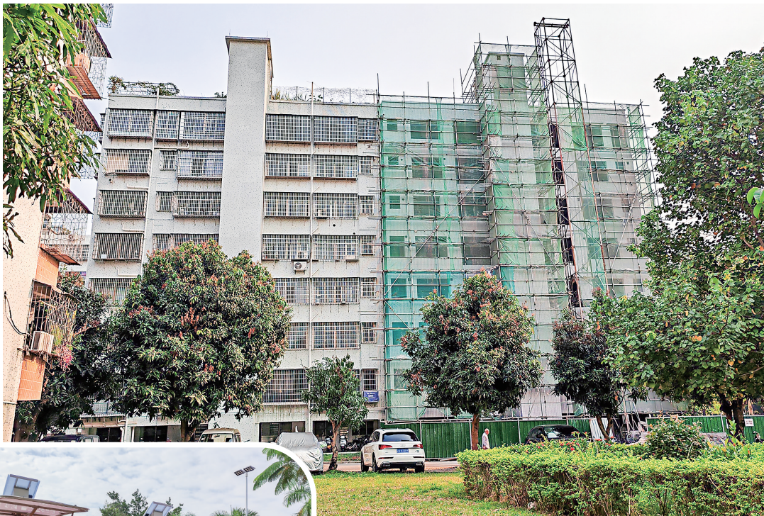
住宅小区加装电梯，解决了居民上下楼不便的难题。
